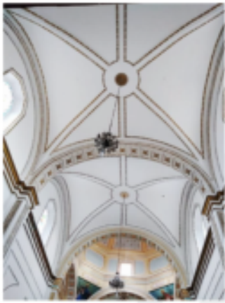
Imagen 8: Bóvedas ubicadas en la nave con dirección al cimborrio
