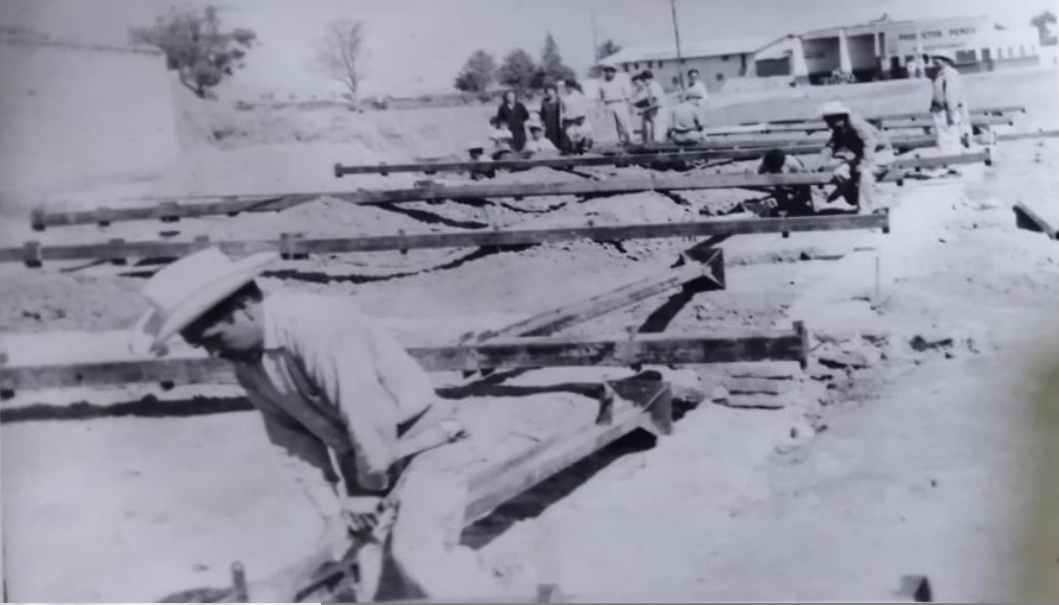
Construcción de las aulas provisionales de la escuela secundaria, año de 1960, fotos propiedad de la Profesora Isaura Flores Trujillo.
