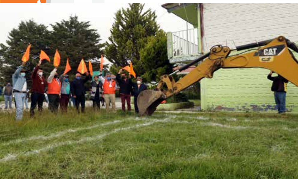
Construcción de Aulas Prim. José María Morelos, San Pedro Cabecera
